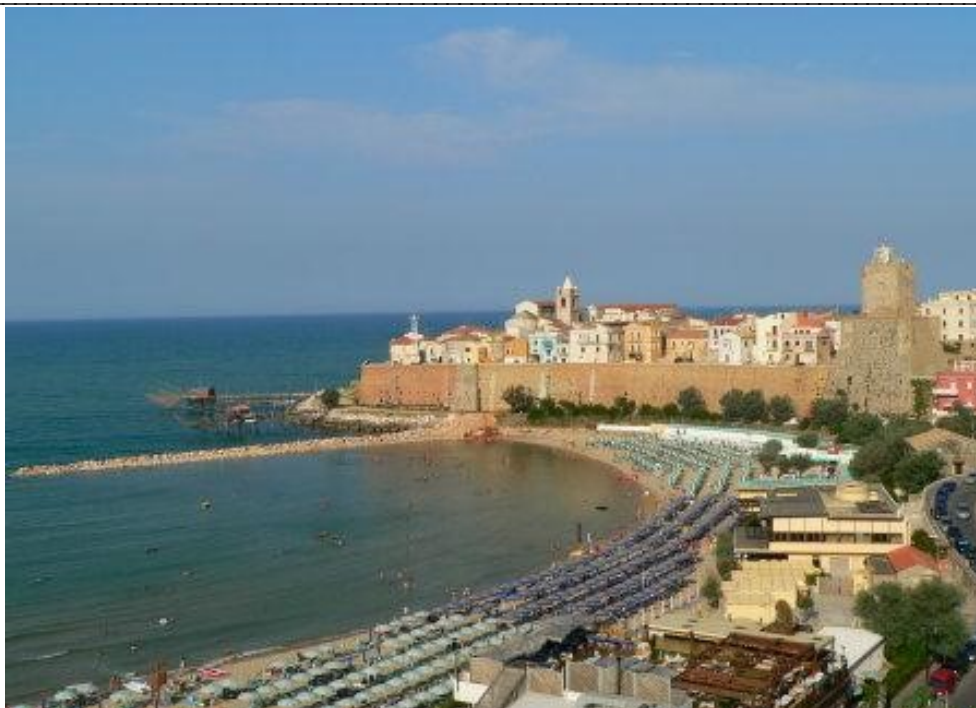
Foto n° 1 Lungomare nord di Termoli particolare della colorazione anomala
